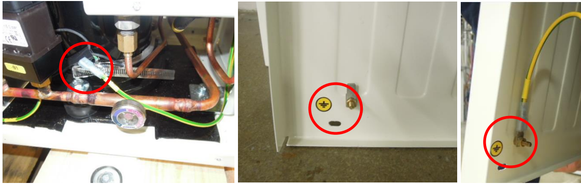
Figure 11 : Détails de la mise à la terre
