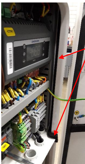
Figure 42 : Inspection visuelle du joint caoutchouc
