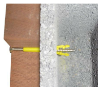
cheville traversante - vue en coupe dans le parpaing
